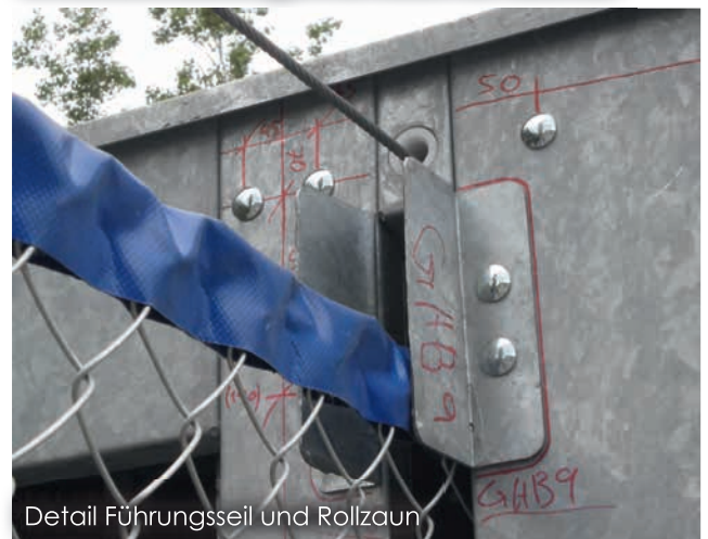
Detail Zaunhalterungen mit Rollen auf dem Seil
